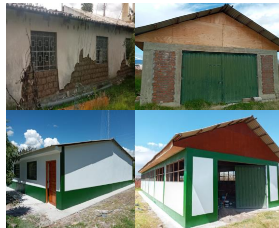
Rehabilitación de Almacén de fertilizantes y Semillas con el PROSEM.
