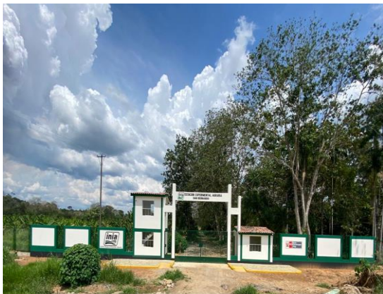
Cerco perimétrico en la EEA San Bernardo.
