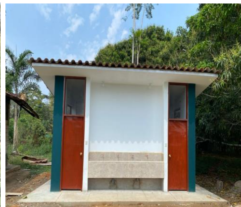
Instalación de Baños en la EEA San Bernardo.
