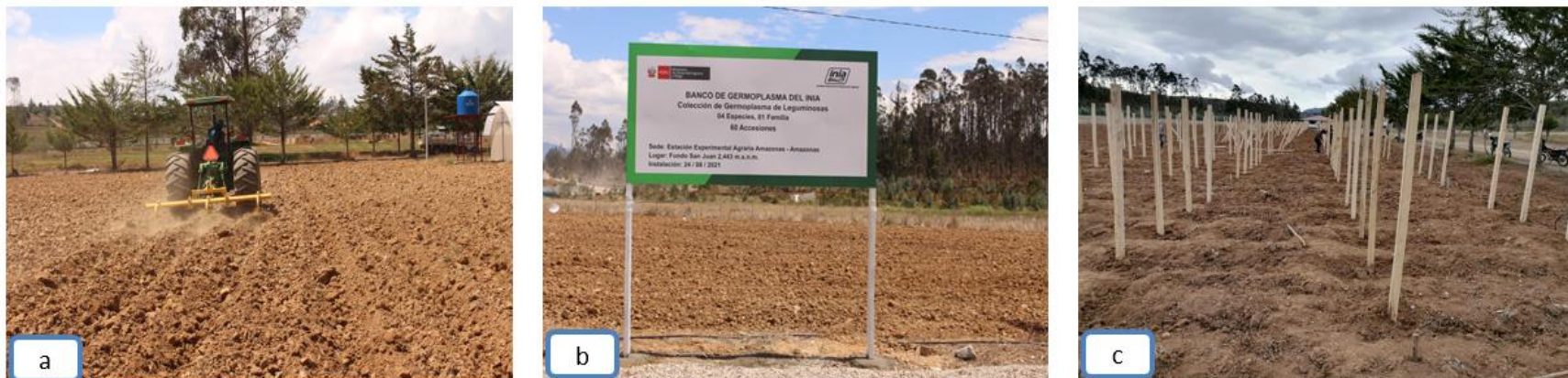
Figura. a. Preparación de terreno para instalación de banco de germoplasma de leguminosas; b. Colocación de señalética de banco; c. Instalación de tutores para leguminoso andinas.
