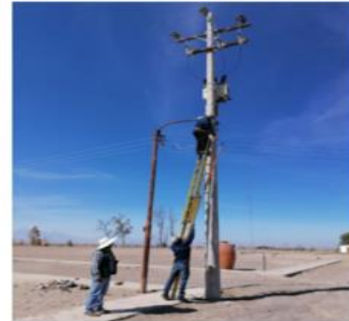
Arreglo de fusible campamento Santa Rita, para restablecimiento la luz eléctrica
