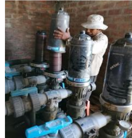
Limpieza de filtros de riego en el cabezal , bajada D1 Anexo de Santa Rita
