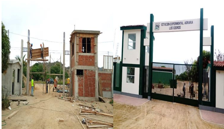
Construcción de cerco perimétrico en la EEA Los Cedros Tumbes.
