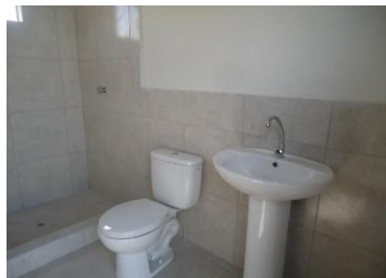
Mantenimiento e implementación con servicios higiénicos, área de vestuario y oficina
