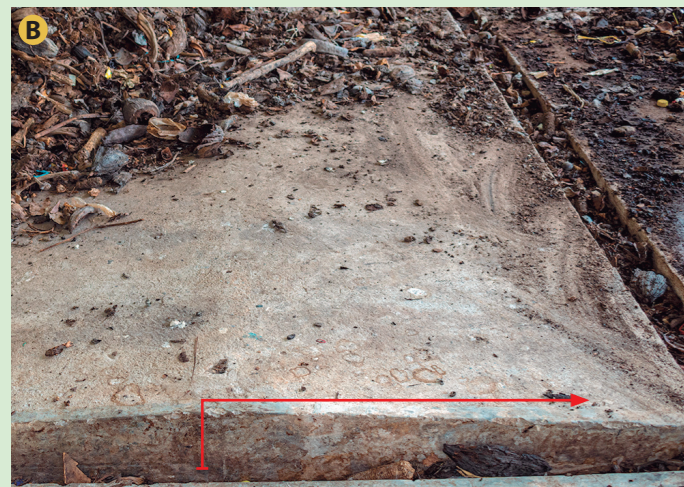
Figura 1. Algunas características de una compostera permanente. (A) Área de compostaje con techo y muro. (B) Piso de concreto con ligera pendiente para el escurrimiento de efluentes
