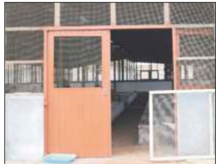
Uso de pediluvios con desinfectante al ingreso de los galpones
