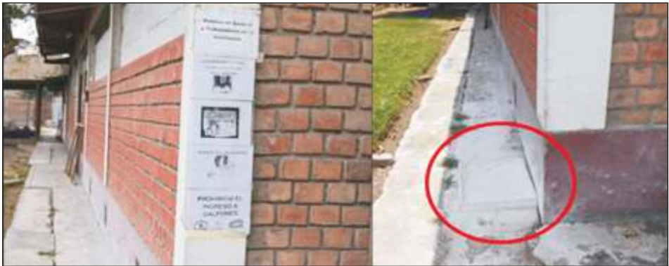
Señalización de los galpones y pediluvio o tapete de cal al ingreso de la granja
